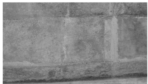
写真-4 壁高欄下部のひび割れ発生状況の例
