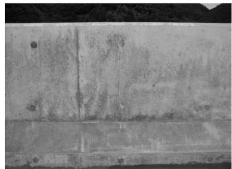
写真-3 初期ひび割れが発生した壁高欄の例
